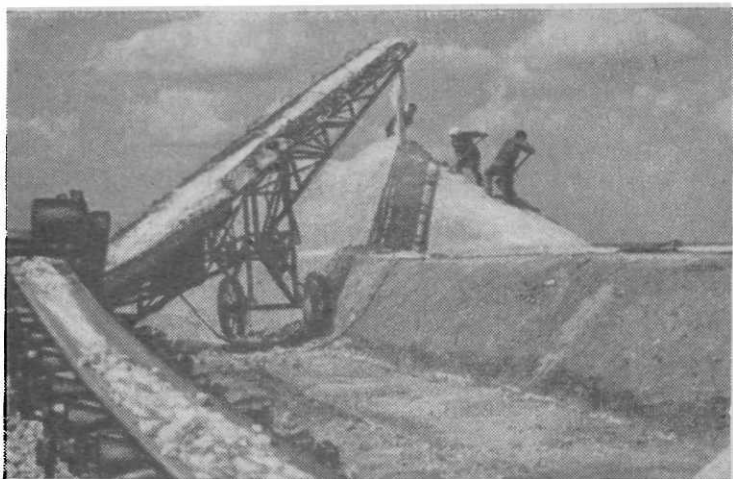
Сиваш и соленые озера Крыма содержат неисчерпаемые запасы соли. На снимке — механизированная добыча соли на Сиваше (Арабатская стрелка).
